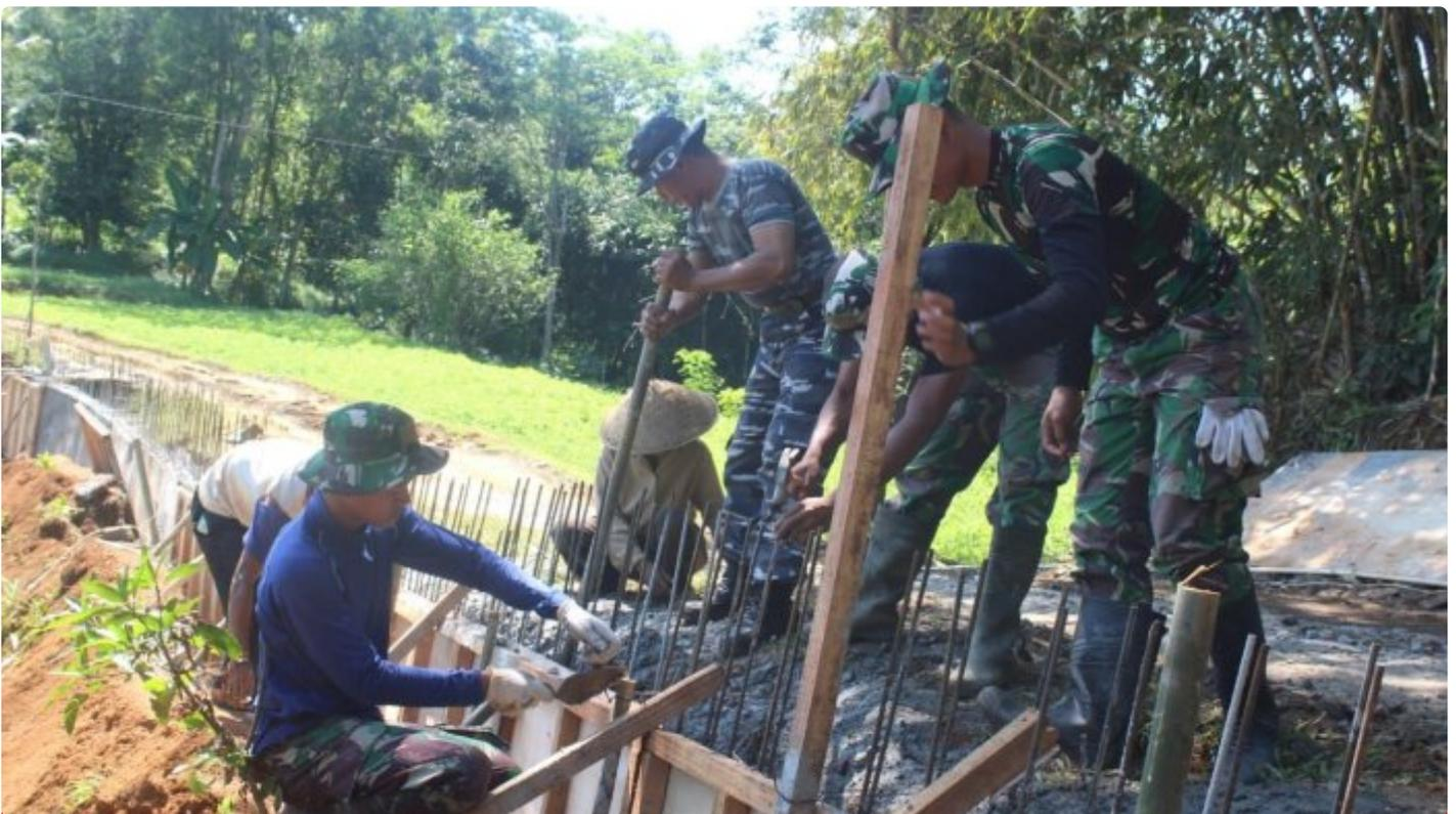
*Pekerjaan talud sudah memasuki tahap pemasangan kerangka dilanjutkan pengecoran yang nantinya untuk memperkuat talud penahan Tebing*
