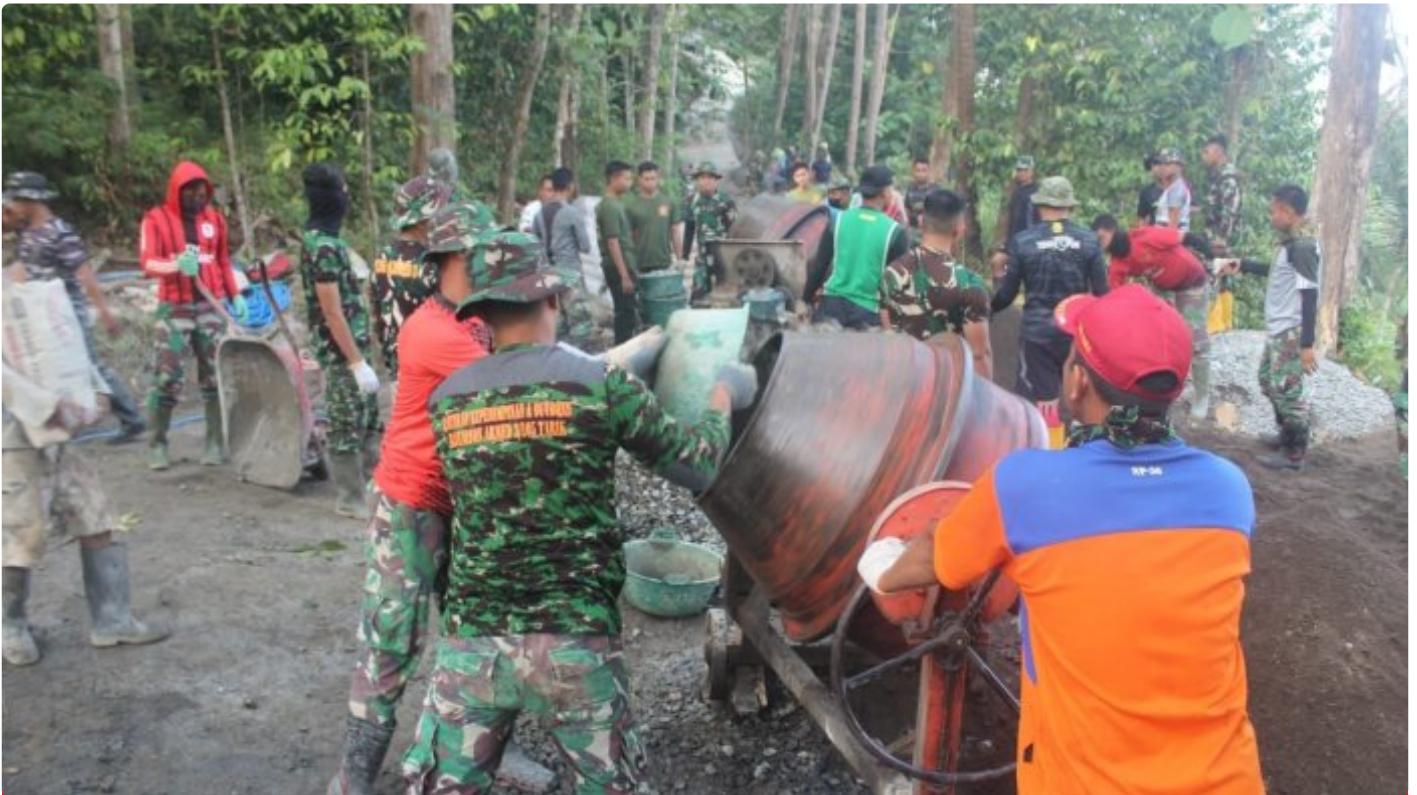
Satgas TMMD Reguler Ke-116 Kodim 0709/Kebumen Bersama Warga terus Pacu Pembangunan Rabat Beton
