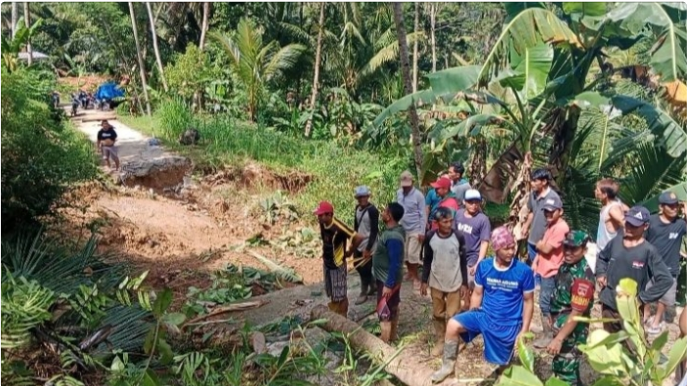
Babinsa Koramil 22/Ayah Peltu Donny Eko Prasetyo mendatangi lokasi bencana alam longsor yang mengakibatkan jalan desa terputus di Desa Karangduwur
