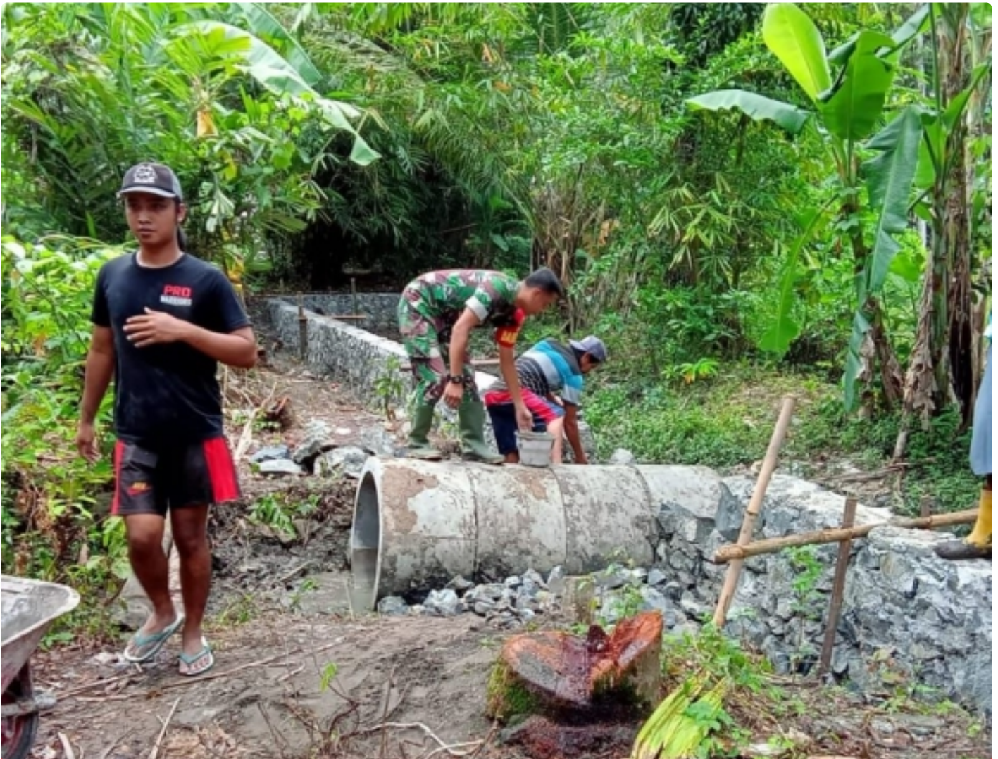
Babinsa Wonoyoso Koramil 19/ Kuwarasan Serda Badri melaksanakan karya bakti pembangunan talud saluran irigasi sekaligus pemasangan gorong gorong bersama warga
