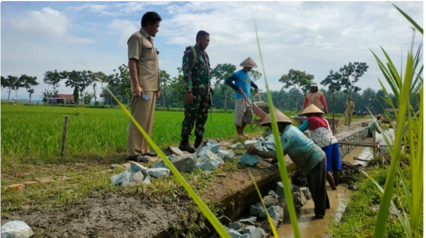
Babinsa Koramil 15/Klirong Pelda Bambang PH mendampingi Pemerintah Desa (Pemdes) cek pembangunan saluran Drainase yang bertempat di Desa Jerukagung
